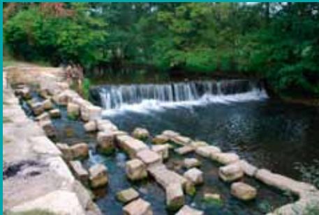
Fischtreppe auf der Syr bei Mertert
